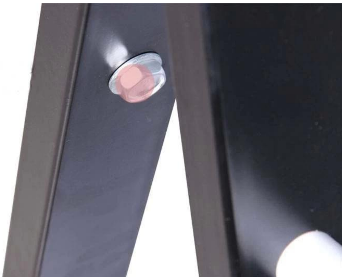
Estrutura triangular poderia estabilize este rack
